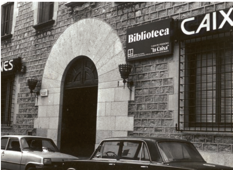
Exterior de la Biblioteca de Llinars del Vallès de la Caixa de Pensions per a la Vellesa i d'Estalvis (1983).
