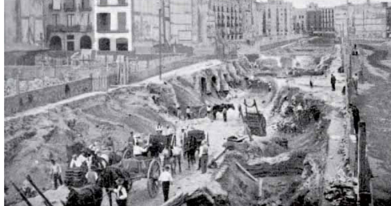
Obres del metro a la Via Laietana, Barcelona. Il·lustració Catalana, 1911.
