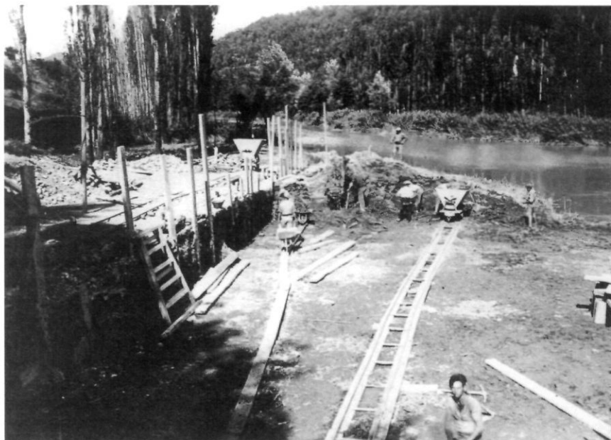
Dues fases de la construcció de la resclosa de la Colònia Vidal, 1896-1898. Arxiu del Museu de la Colònia Vidal.
