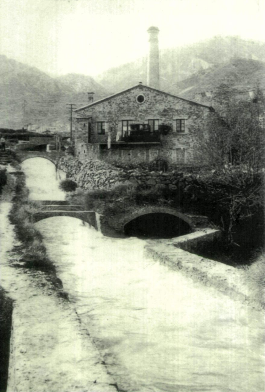
Les indústries incipients sovint aprofiten les estructures artesanals més antigues. És el cas d'aquesta fàbrica d'electricitat instal·lada en un vell molí fariner, a Berga (Foto arxiu del MCTC)
