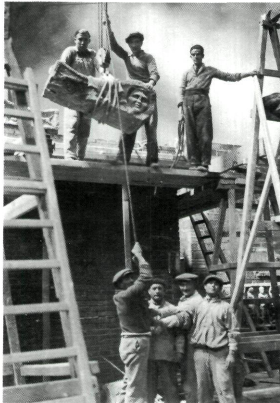
1934. Instal·lació de les peces durant les obres de transformació i adaptació del Palau de les Arts Gràfiques (Foto MAB).
