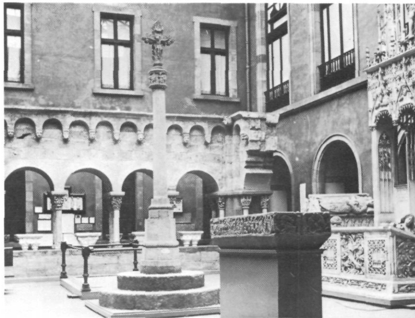
Pati i interior del Museu d'Art i Arqueologia instal·lat al Parc de la Ciutadella (Fotos IMH).
