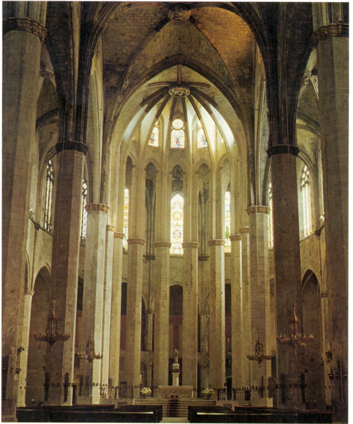
Santa Maria de la Mar, obra mestra del gòtic català, mostra una coherència notable, gràcies a haver estat construïda amb una rapidesa inusitada en un edifici de proporcions tan grans. Les obres, que foren dirigides per Berenguer de Montagut, començaren el 1328 i culminaren el 1383 (excepte la torre meridional, la qual fou acabada l'any 1909). Vista de l'absis que permet d'apreciar també algunes de les notables vidrieres del temple (Foto R. Manent).
